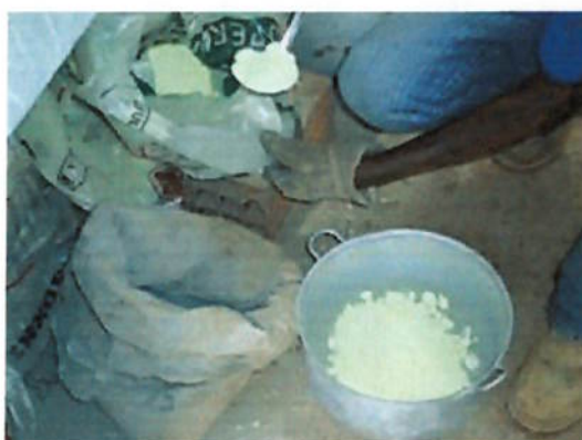
Figura 15 – Mistura de enxofre com cimento na proporção de 3:1
